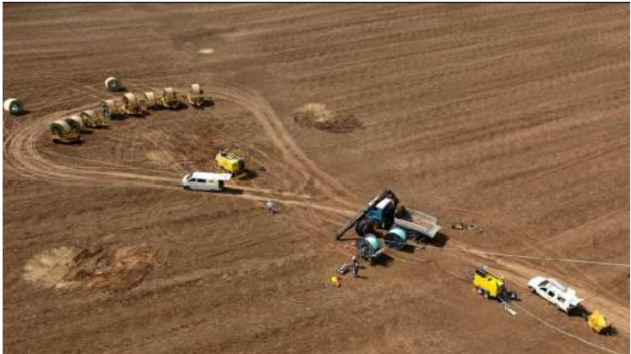
Abbildung 23: Trommel- und Windenplatz für den Seilzug
