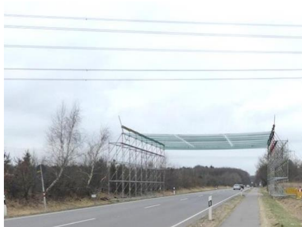
Abbildung 28: Stahlgerüst mit Netzeindeckung
