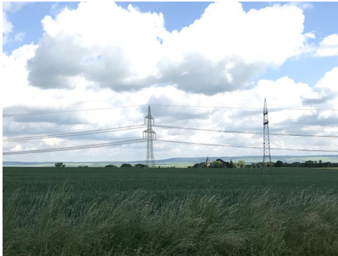
Abbildung 35: Blick auf die Dorfkirche Wenigenehrich (geplante 380-kV-Freileitung im Vordergrund)
