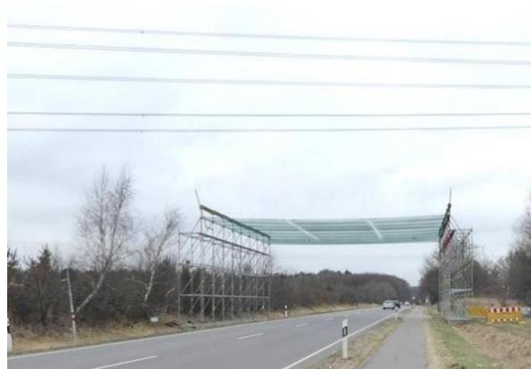
**Abbildung 12: Stahlgerüst mit Netzabdeckung**
