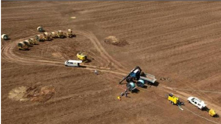
**Abbildung 7: Trommel- und Windenplatz für den Seilzug**
