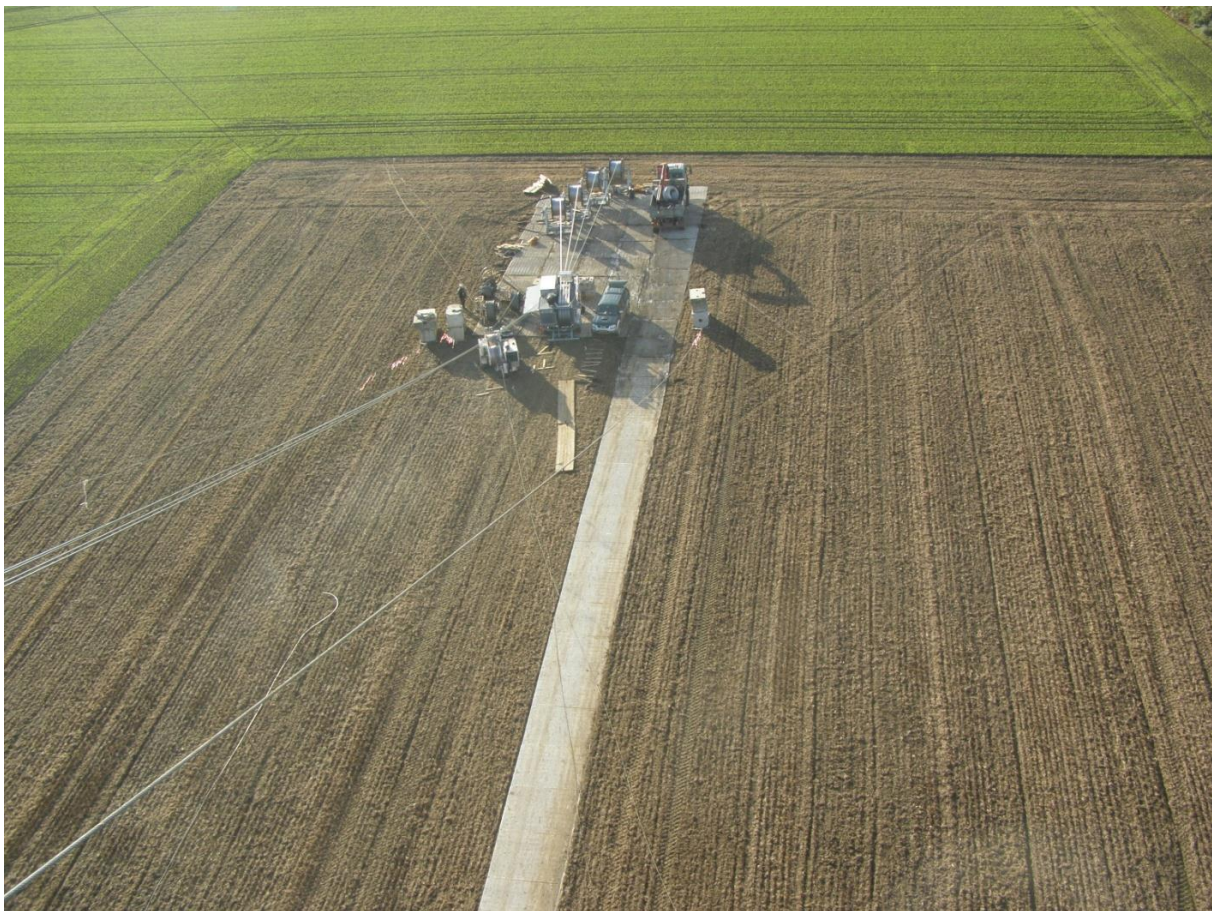
Abbildung 20: Windenplatz eines Viererbündel-Seilzuges (Quelle: Amprion GmbH)
