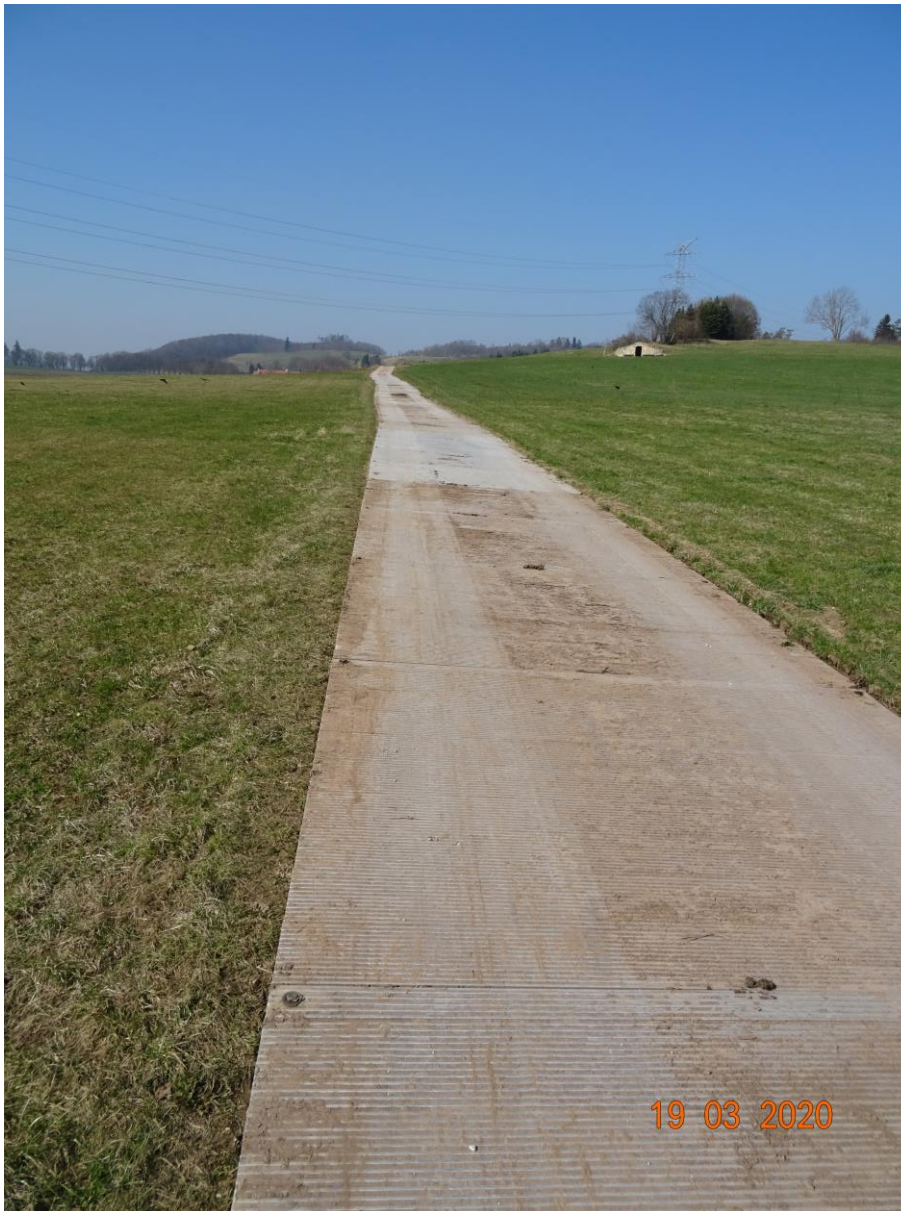
Abbildung 15: Temporäre Zuwegung über Fahrplatten (Quelle: Amprion GmbH)
