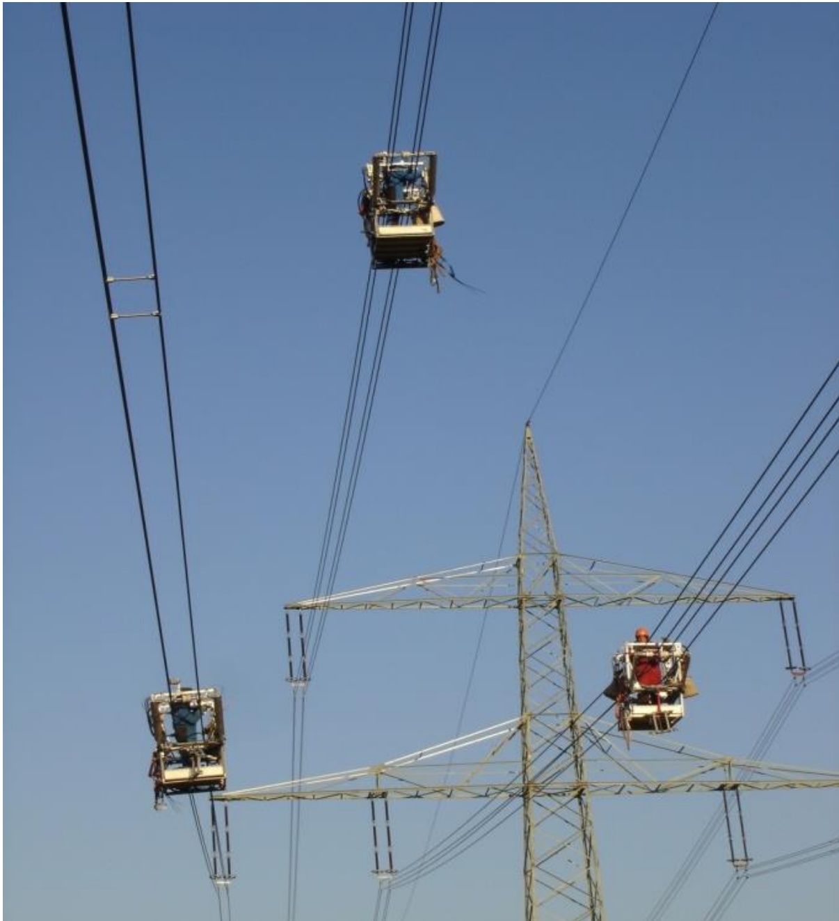
Abbildung 21: Montage der Feldbündelabstandhalter mit Fahrwagen (Quelle: Amprion GmbH)
