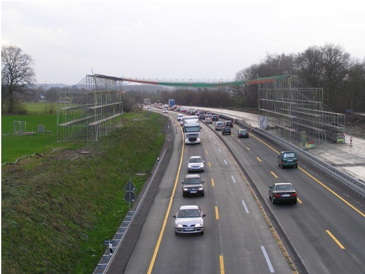
Abbildung 19: Stahlrohrschutzkonstruktion mit Netz über einer Autobahn (Quelle: Amprion GmbH)
